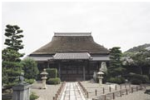
写真2 景観上重要な建造物西願寺（登録文化財）
