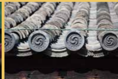
丸瓦と平瓦を使う「本瓦葺」の軒先の軒丸瓦と軒平瓦蓮の花
