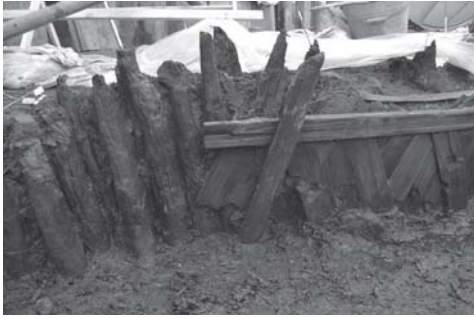
写真5 斜交薄板と高密度杭列の土留め (塩津港遺跡)
