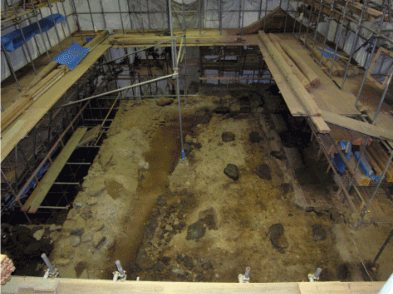
庵室 前身基壇(東から)
