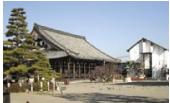
大通寺本堂と修理中の太鼓楼覆屋
